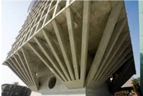
FIGURA 1 . EDIFICIO CONSTRUIDO CON CONCRETO DE ALTA RESISTENCIA.
